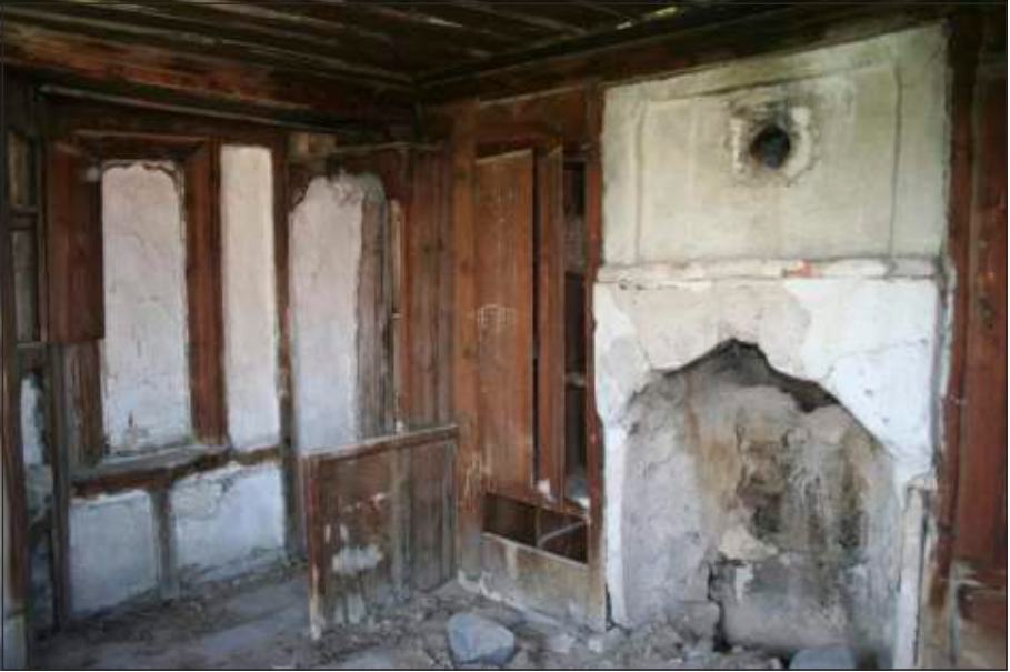
Resim-41 Sıva ve Kireç Badana, Çavuşlar Mahallesi, Ahmet Biçer Kara Hafızgil Evi
