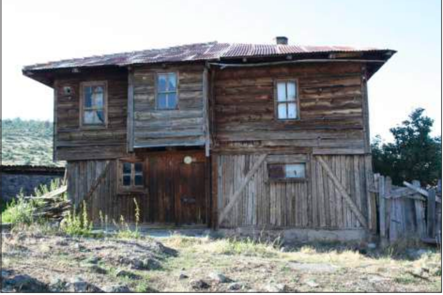
Resim-40 Malzeme-Teknik, Orta Köy, Zehra Ünal Evi
