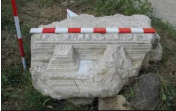
Resim 20 Seyitköy, üst yapı bloğu
